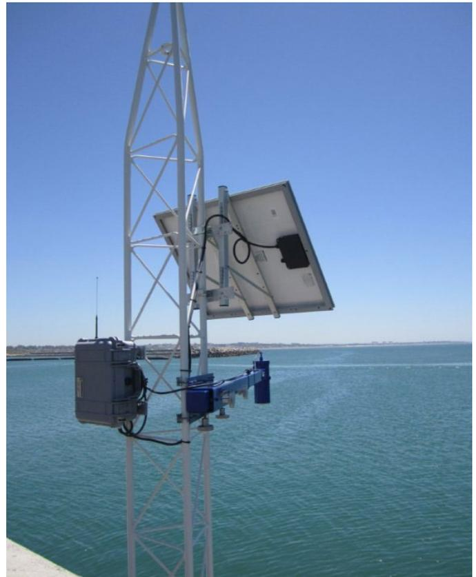
Montaje al aire del sensor RADAR-6115 de nivel sobre torreta y brazo soporte extensible
